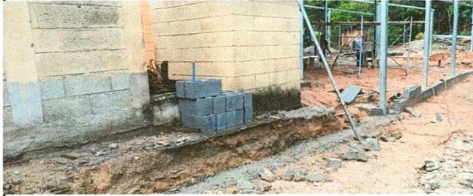
Foto 1: Reparación de muro perimetral por hundimiento
