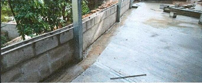
Foto 1: Reparación de canales y bajadas de agua pluvial (elaboración de canaleta de piso con rejillas para corrimiento de agua pluvial)
