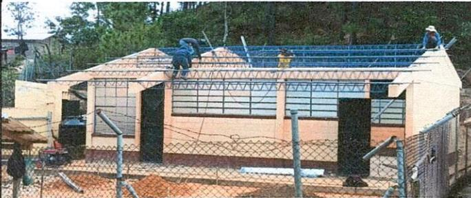
Foto 3: Reparación de estructura de techo
